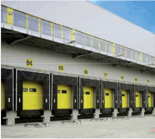
Vista exterior muelles de carga
